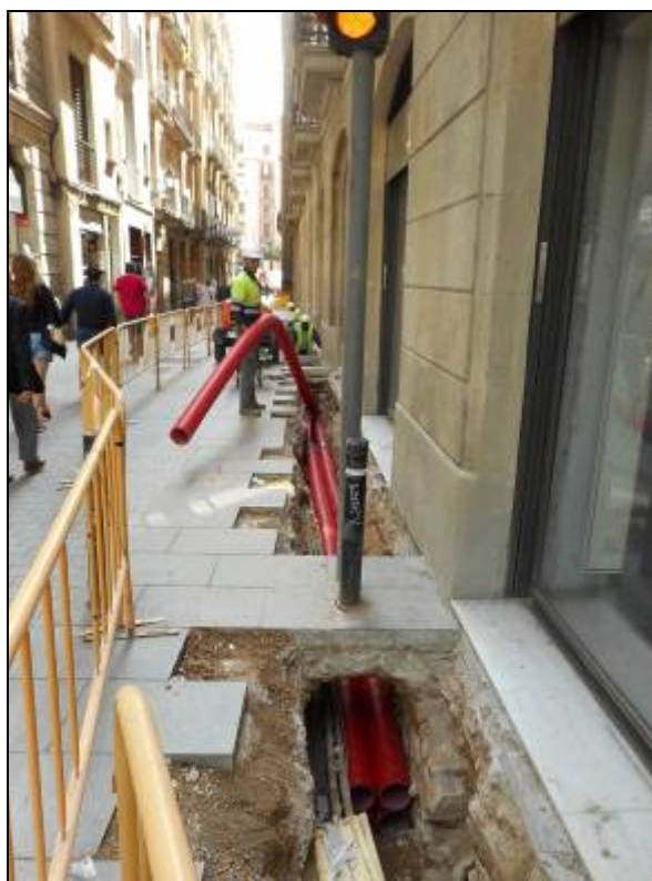
4. Instal·lació de tubulars al tram de rasa del carrer Canuda núm. 2.
